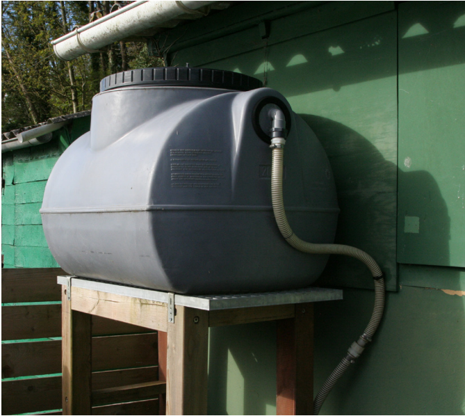
Image 5 : Première cuve du système de filtration permettant la décantation des eaux sales et la récupération des déchets - © Gilbert PLOE
