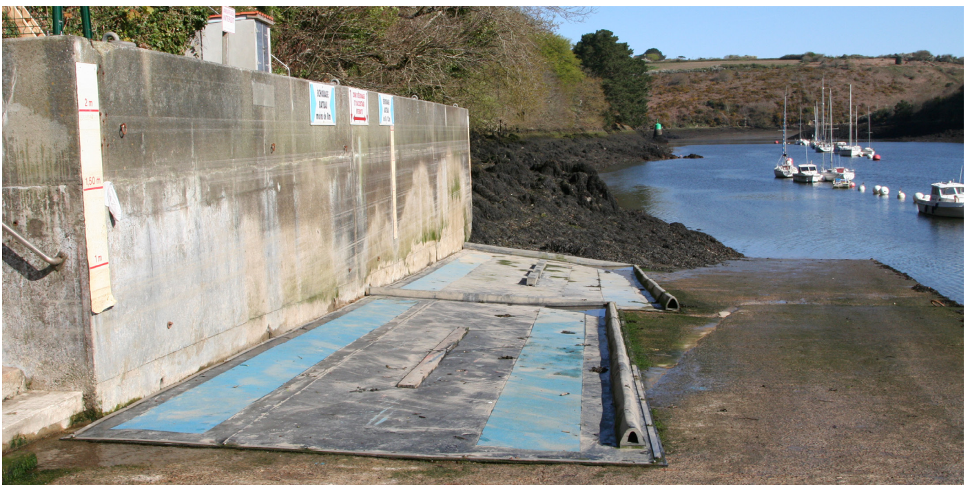
Image 1 : Tapis permettant le positionnement des embarcations sur l'aire de carénage de Paluden (29) © Gilbert PLOE - A.P.S.A.P
