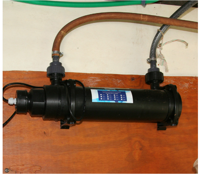
Image 6 : Filtre à U.V permettant de réduire les mauvaises odeurs pouvant émaner de l'eau recyclée. Le filtre à U.V est dissocié des autres filtres - © Gilbert PLOE
